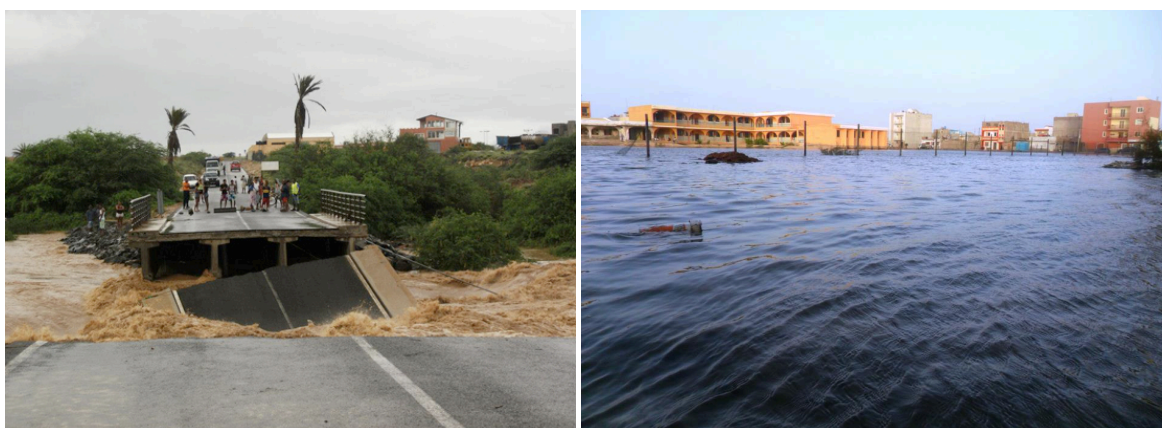
Figura 31 Ilha da Boavista: Destruição de infra-estruturas e inundações em 2012. Fonte: Tith Ramos
